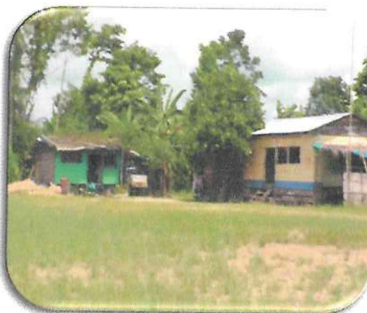
Foto 6. Viviendas sin Energía Eléctrica
