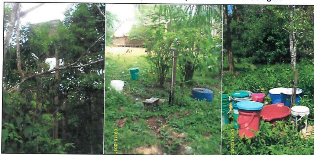
Ilustración 14, 15 y 16. Tanque Elevado y Abastecimiento de Agua.
