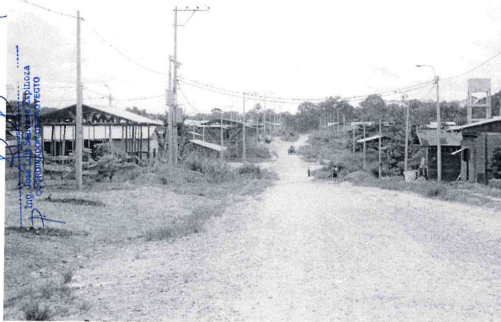
La conexión eléctrica pública y domiciliaria en Villa Toledo.
