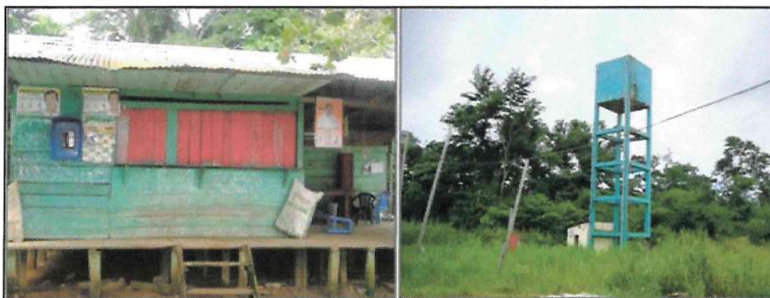
Figura 7. Teléfono Comunitario y Tanque Elevado de Agua
