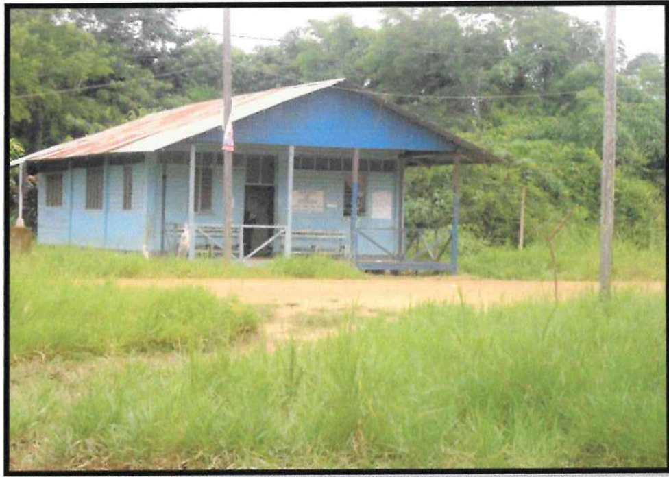
Fotografía N°5. Puesto de Salud
