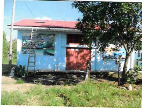
Foto N° 03: Puesto de Salud de Nivel 1-2 S/M del centro poblado Shintuya
