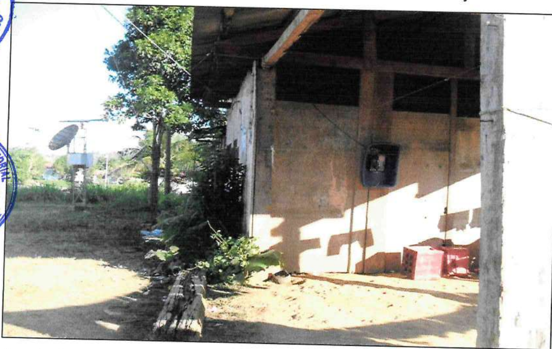
Foto N° 7: Módulo telefónico satelital del centro poblado Shintuya.
