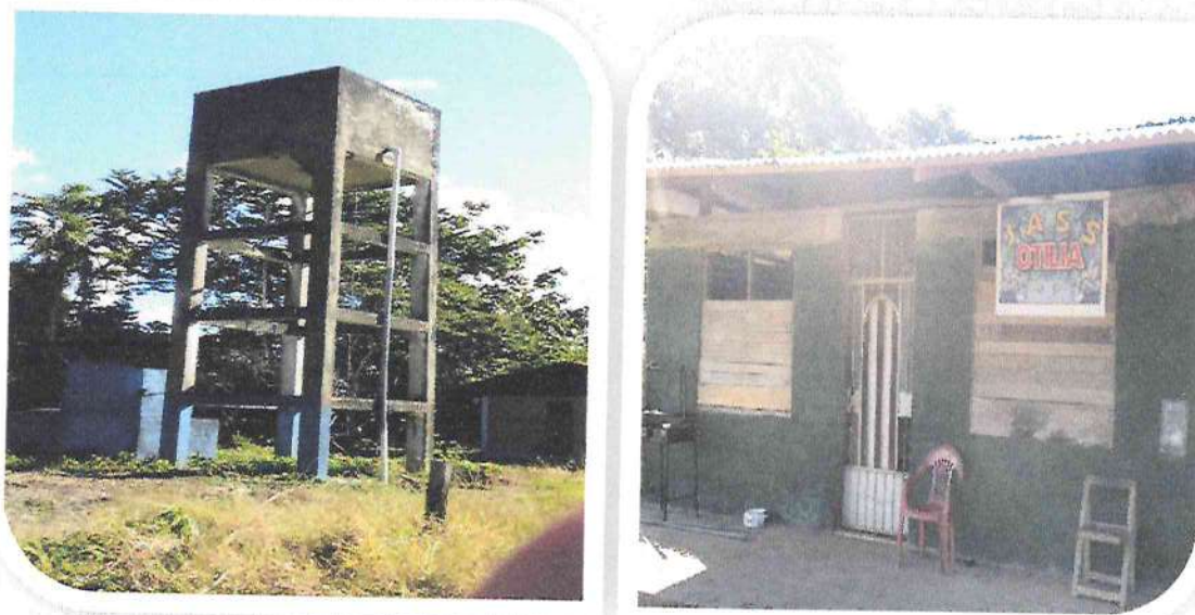
Foto N° 3. Tanque elevado para la distribución del agua y oficina del JASS –El Prado.
