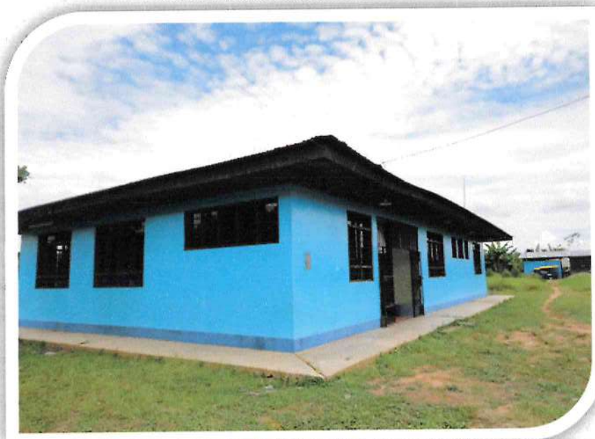
Foto N° 7. Puesto de Salud Sudadero
