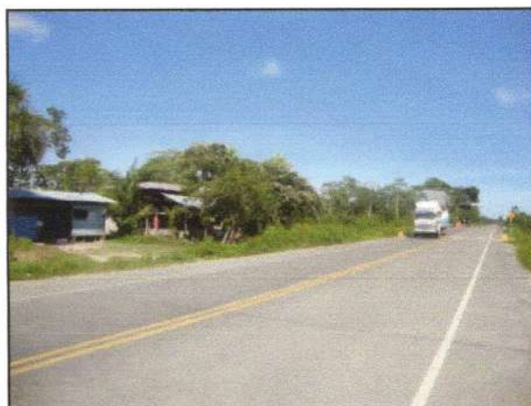
Figura 6. Interoceánica Sur altura de Santa Rita Baja
