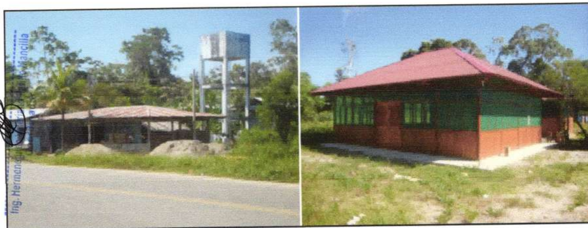
Figura 5. Viviendas y Oficina de Proyecto Agroforestal
