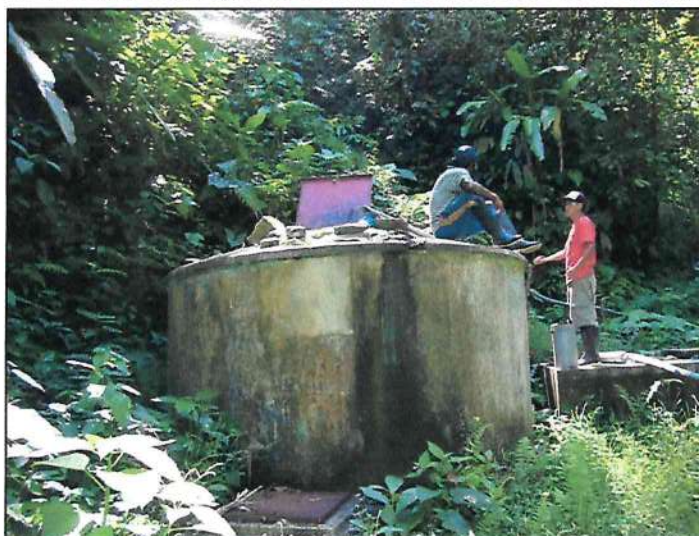
Figura 16. Tanque de Agua Captada Directamente de la Quebrada.
