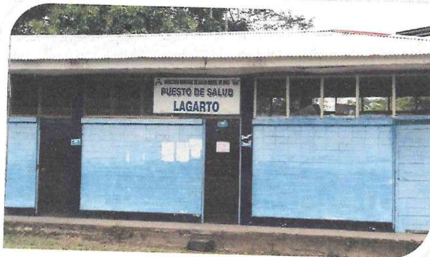
Foto 3. La Infraestructura Puesto salud -Lagarto.
