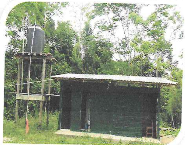
Foto N° 4. Tanque elevado para la distribución del agua.
