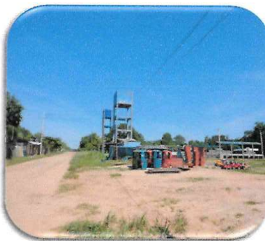
Foto N° 7. Servicio de Agua
