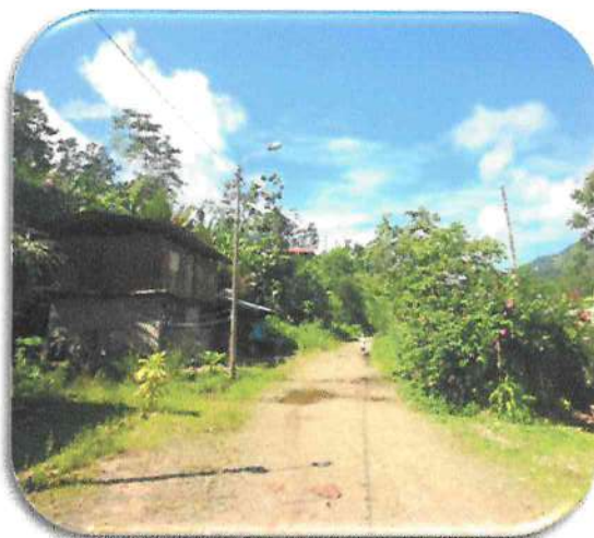
Tramo de la carretera Pilcopata-Shintuya en el sector de Gamitana mostrando la red eléctrica secundaria
